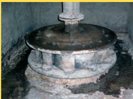
Die freigelegte Francis-Turbine
