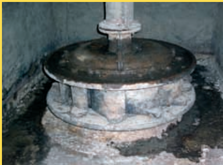
Die freigelegte Francis-Turbine
