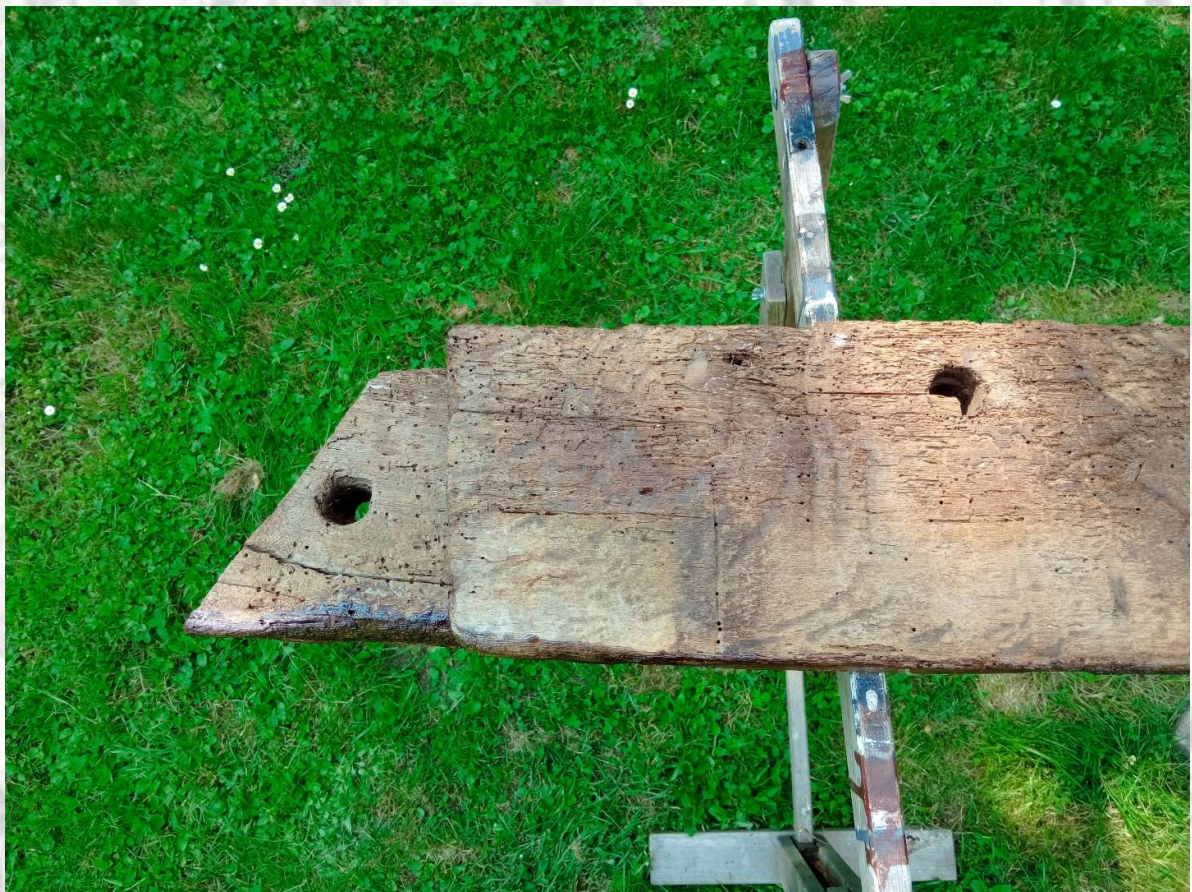
Abbildung 1 - Gereinigte Schwelle
